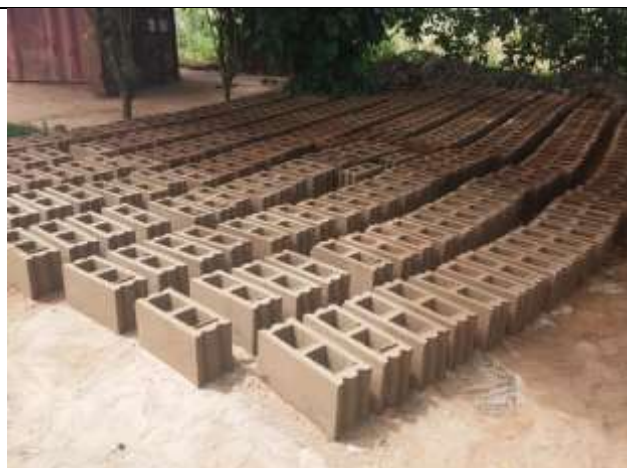
写真 3：支出を抑えるため、ブロックは型枠を使用し自作
