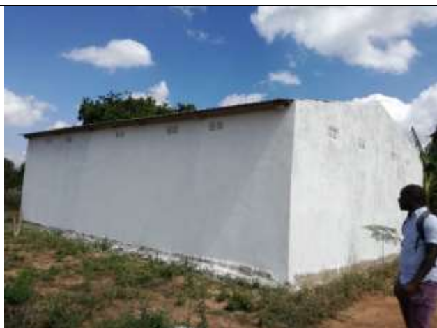
写真 3：加工施設完成
