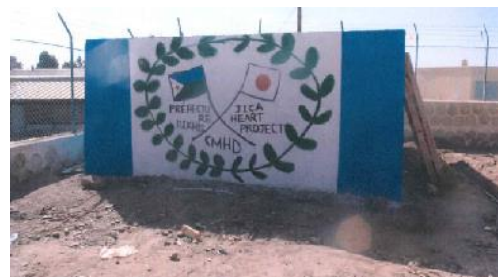
2016 年 12 月、病院に貯水槽が完成し、病院内の各科に貯水槽からの水が行き渡りました。
